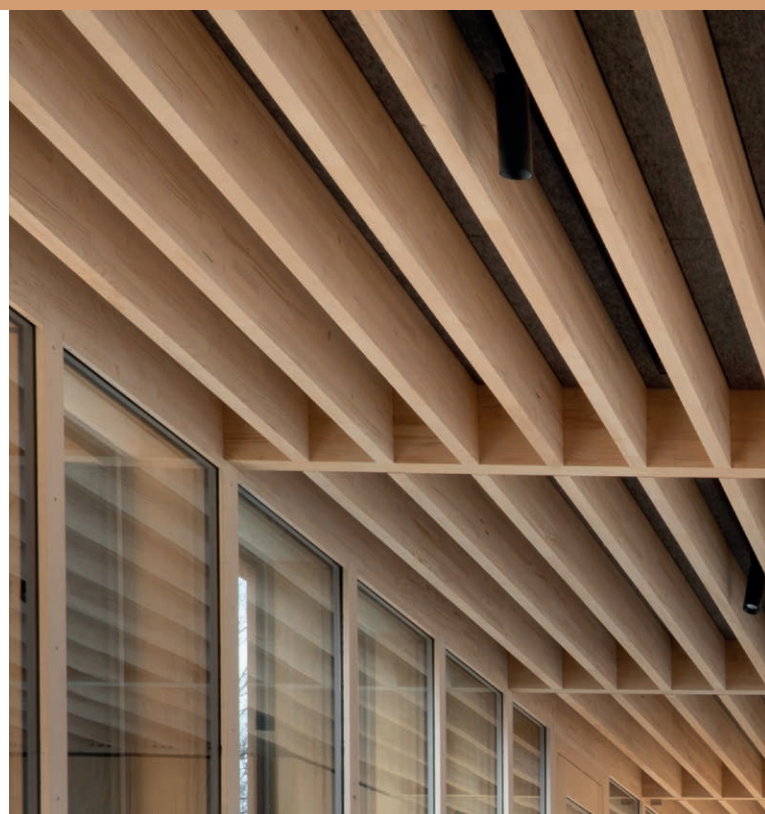
Ansicht der Deckenkonstruktion
